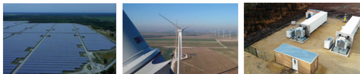
Figure 4 : de gauche à droite, Centrale Solaire de Cestas (300 MWc), Centrale Eolienne de Bussy-Lettrée (26 MW), et Azur Stockage (6 MW, 6MWh) (source : Neoen, 2019)
