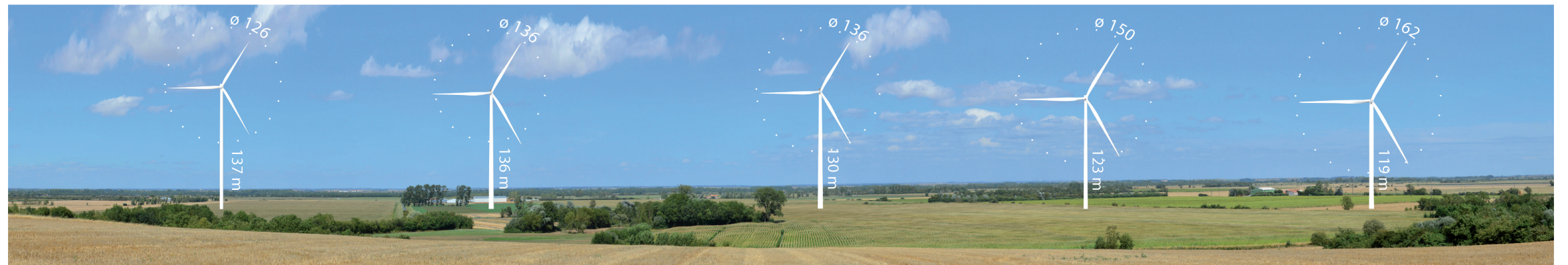
Figure 20 : Exemple du rapport de proportion entre le diamètre du rotor et la hauteur de mât (éoliennes de 200 m en bout de pale).
