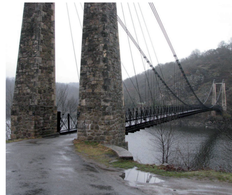
Figure 8 : Pont suspendu de Saint-Marien, 1920-1921. Photo : Maria-Andreea Grecu. © DRAC Nouvelle-Aquitaine
