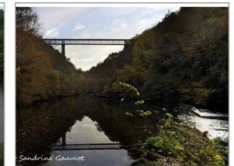
Viaduc de la Tardes
